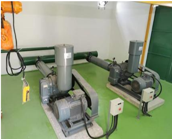
Projek pemasangan turbo blower yang berjaya dilaksanakan oleh IWK
