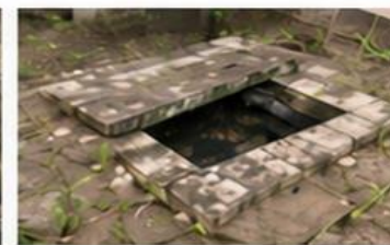
Penutup tangki retak / pecah
