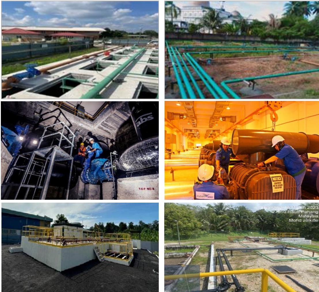
Kerja-kerja membaikpulih dan menaiktaraf aset pembetungan
