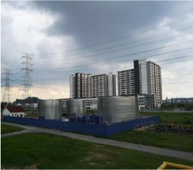
RSTP Setia Alam 1 WRP – 4 MLD
